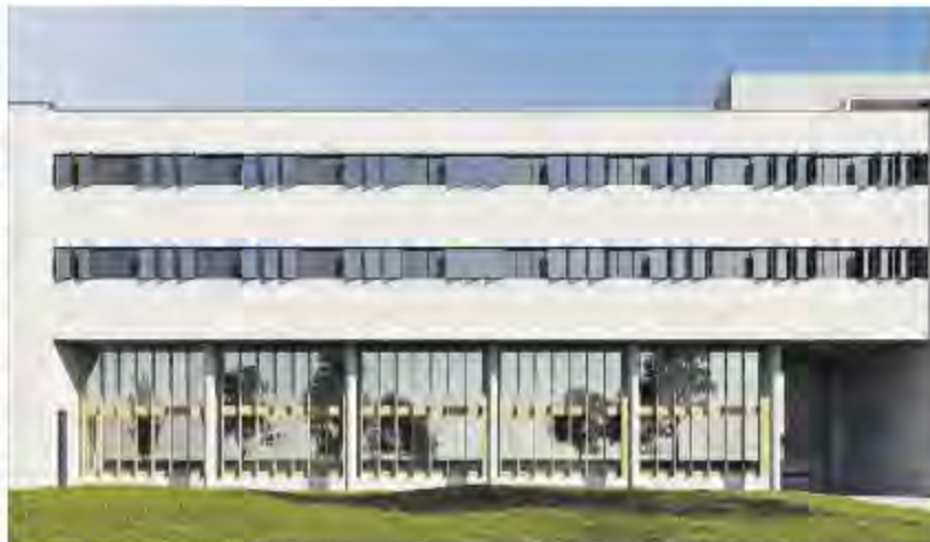
Infografía del proyecto de ampliación, resuelto con dos plantas en el espacio de los soportales. V. Ferras
