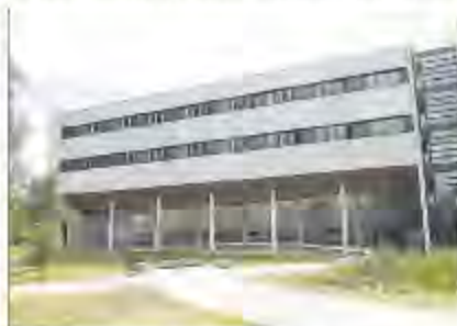
Bloque en el que se realizarán las obras. V. Ferras
